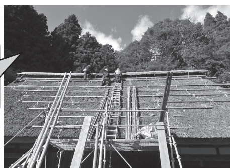
▲屋根棟部分の傷んだホテ(茅束で造った棟飾り)などの取替作業の様子 茅は遠く阿蘇から調達しました
