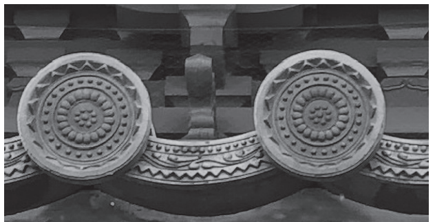
豊前国分寺三重塔軒丸瓦 (出土資料から復元され改修の際に葺き直されたもの)
