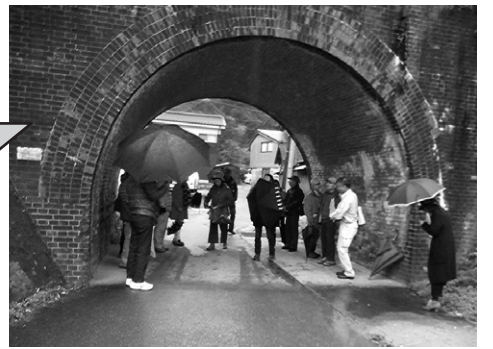
▲生活道路をまたぐレンガのトンネルは明治の鉄道遺産でした
