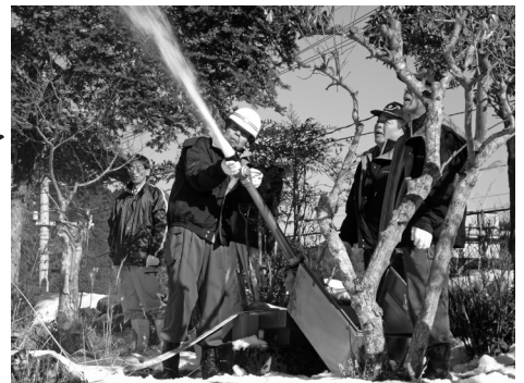
▲備え付けの放水銃を点検操作し、有事への対応を確認しました。
