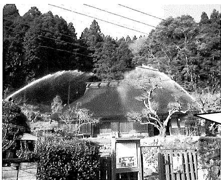
▲放水銃 放水点検
