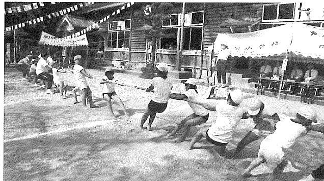
▲旧犀川町立鑑畑小学校 平成6年9月撮影
