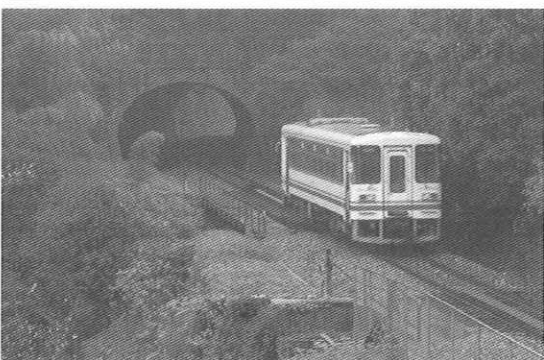
▲現在の石坂トンネル
