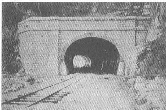
▲完成まもない石坂トンネル
