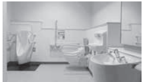
車いすでも使いやすい十分な広さがある身障者用トイレ
