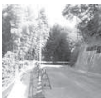
土砂が除かれ通行可能となった(燈畑)
