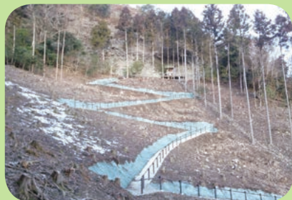
完成した遊歩道
