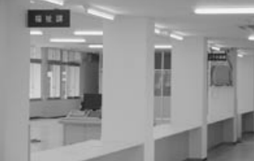
↑アスベスト除去工事が完了した豊津支所
