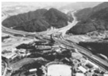
↑今後、高速道路の工事が進むと予想されています（写真は北九州JCT上空）
