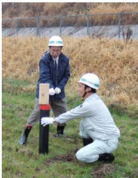
- 東九州自動車道の幅杭設置 -
