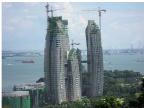
こんな変な形のビルが建設中！
