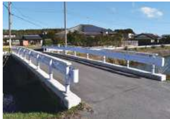
補修した橋梁
