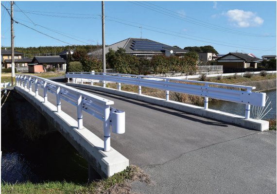
補修した橋梁
