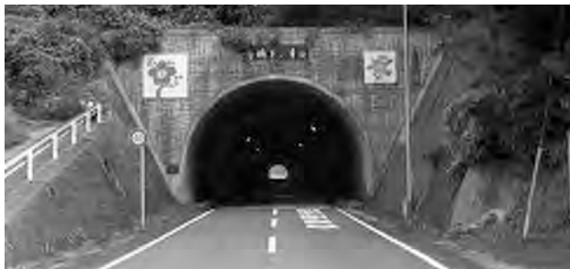
広域農道 葛城トンネル（築上町）
