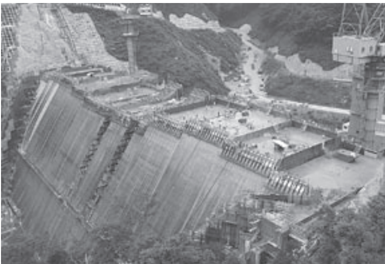
建設中の志津見ダム
