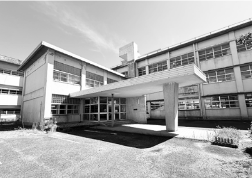
旧豊津小学校校舎 解体前
