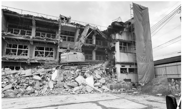
旧豊津小学校校舎 解体中
