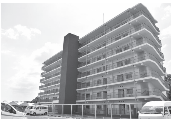
令和4年度完成の上荒谷団地
