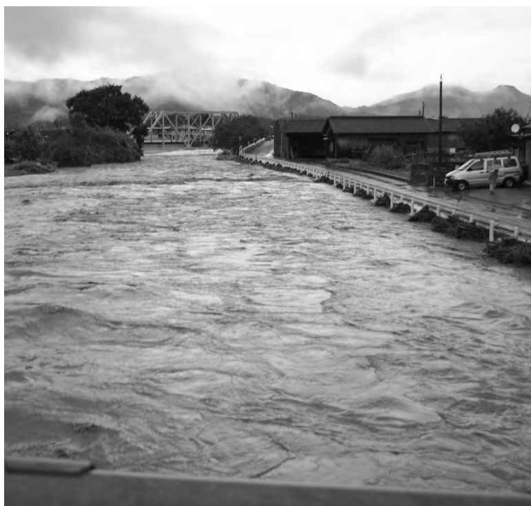
大雨で増水した喜多良川
