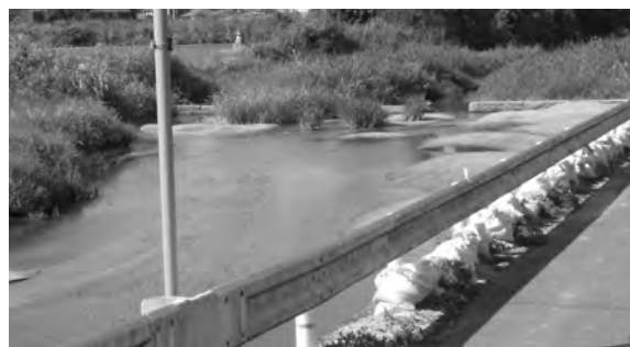
喜多良川の横に積まれた土のう
