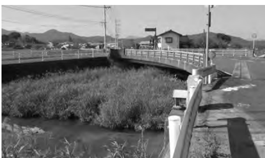
県営高屋川（下高屋橋付近）
