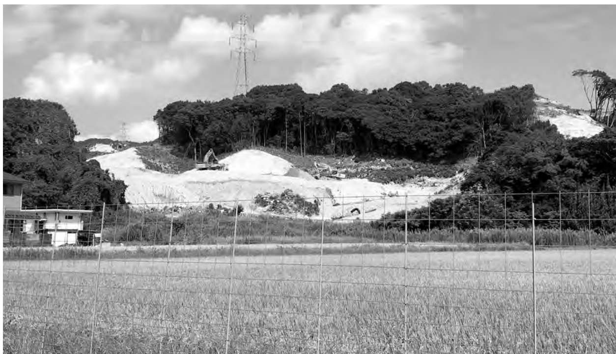
犀川大坂から見た開発中の太陽光発電予定地
