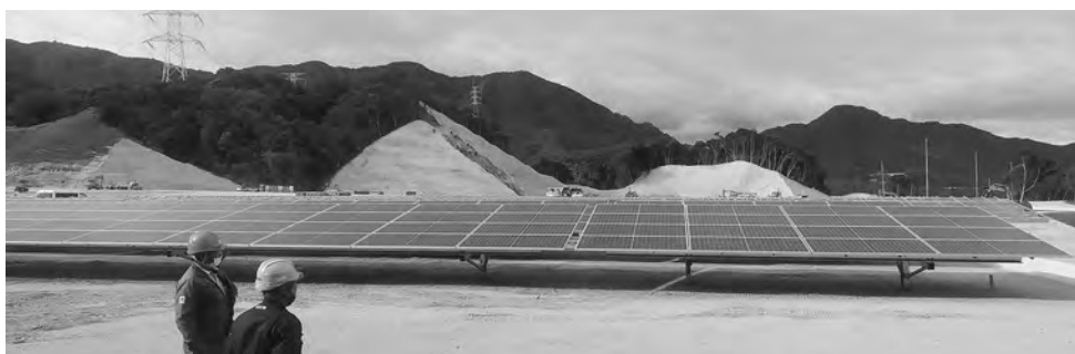
建設中の大規模太陽光発電
