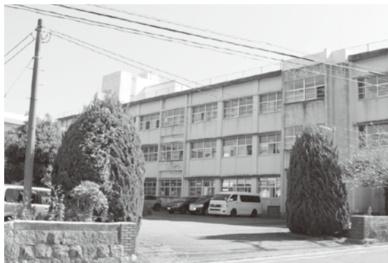
新校舎の建設が予定されている豊津小学校
