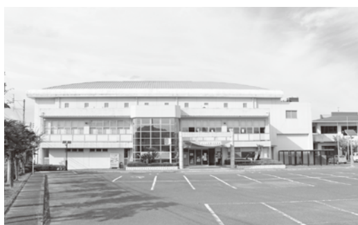
空調機が整備されている犀川体育館
