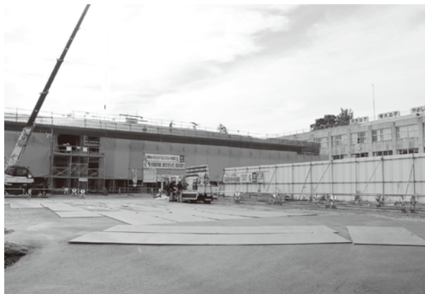
建設中の犀川小学校
