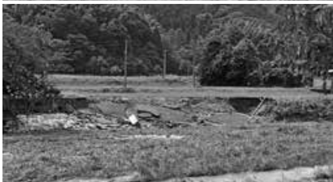
昨年の豪雨災害による被災状況（崎山）
