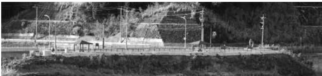
トイレの確保が急がれる伊良原ダム展望台
