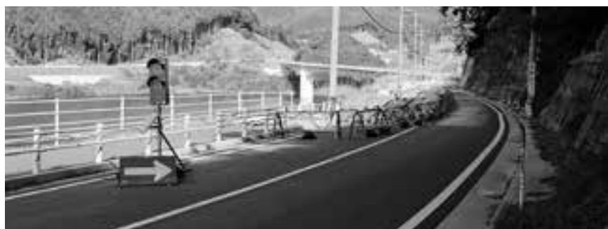
片側通行となっている国道496号
