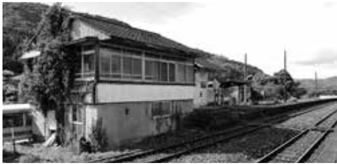
2階建ての崎山駅舎
