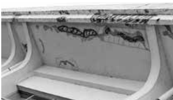
落下の危険性がある外部上部モルタル
