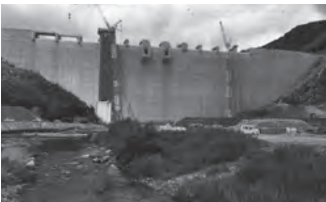
建設が進む県営伊良原ダム
