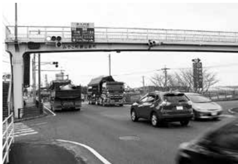
混雑する国道201号線 勝山新町交差点
