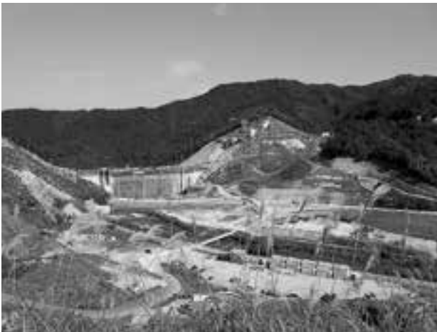
伊良原ダム建設現場
