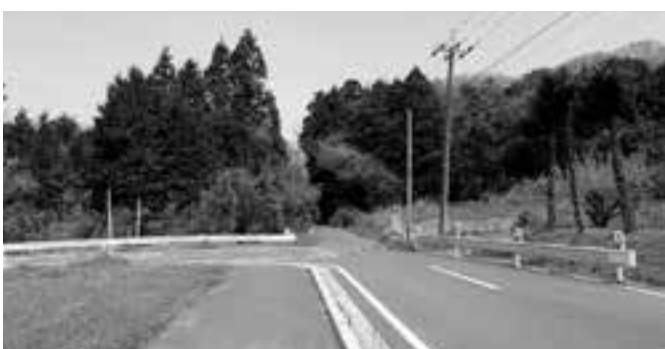
県道下深野〜犀川線(久富区)
