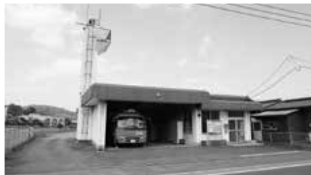
京築広域圏消防本部勝山出張所
