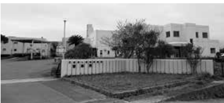
行橋市し尿処理施設
