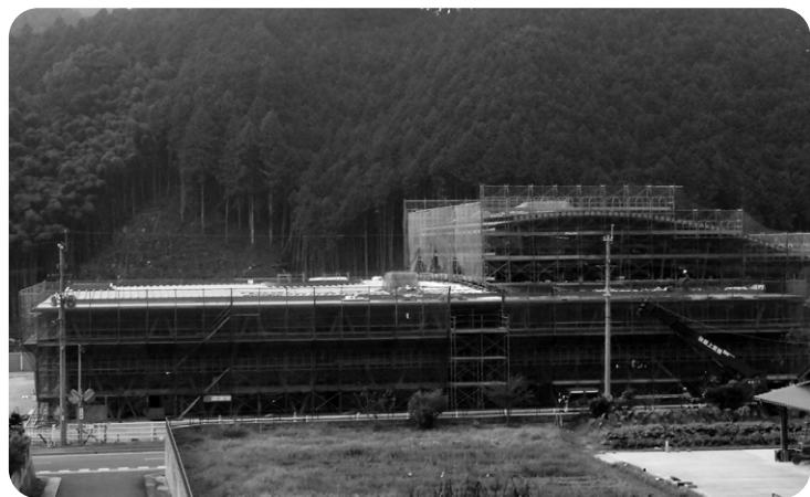
建設が進む伊良原小中学校新校舎
