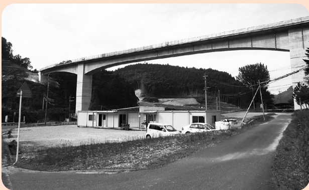
ダム湖を横断する付替国道11号橋
