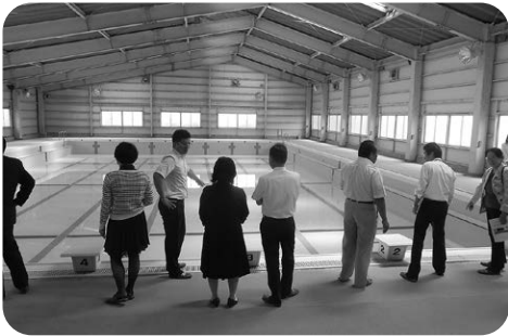
勝山中学校屋内プール
