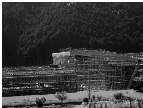
伊良原小中学校の建設状況
