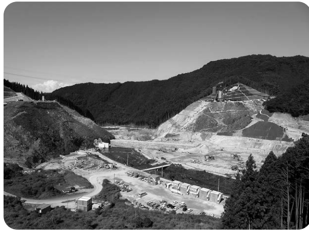
伊良原ダム本体工事現場
