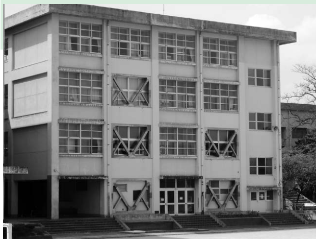
耐震工事が終わっている豊津小学校
