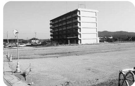
今里団地(第2期)建設予定地
