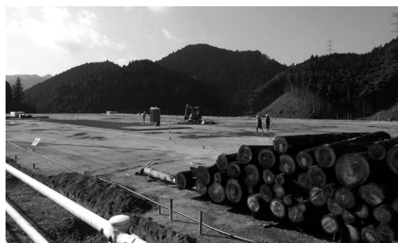
伊良原小・中学校建設現場
