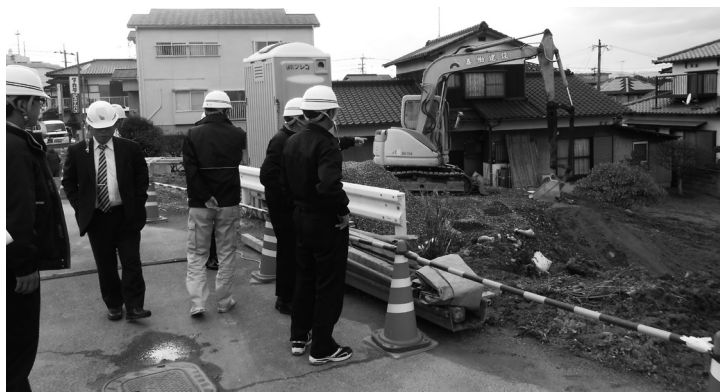
豊津地区冠水被害防除工事
