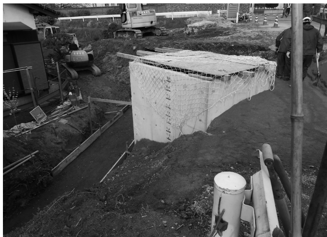
用悪水路工事現場の様子
