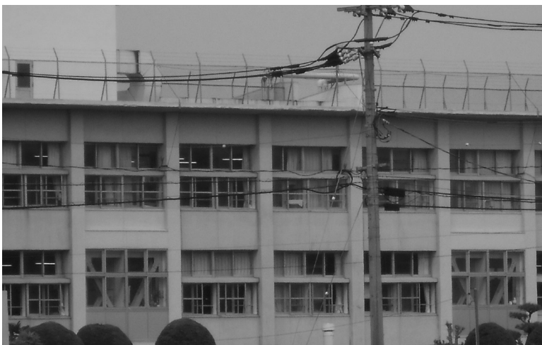
耐震構造化がされている校舎
