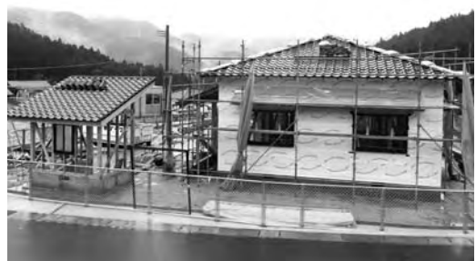
古賀団地内の公営住宅
