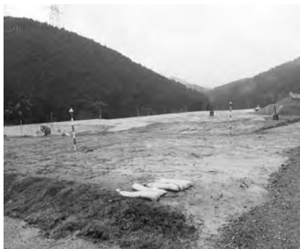
伊良原小中学校建設予定地
