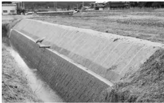
復旧工事の状況
