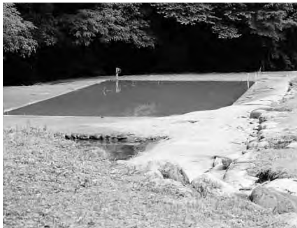
伊良原河川プールに流れ込んだ土砂
