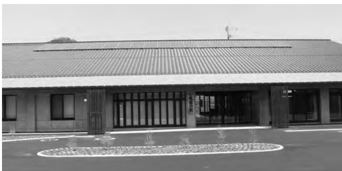
伊良原コミュニティセンターの太陽光発電システム
