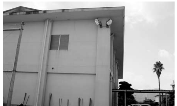
勝山中学校グラウンドの照明設備
