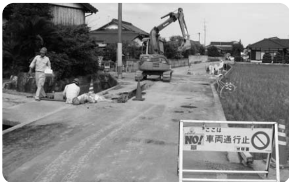
過疎債で行っている中央地区配水管敷設工事(勝山黒田)
