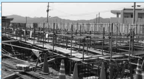
建設中の5階建の三島団地（勝山）
