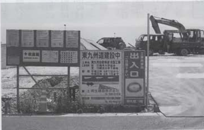
建設中の東九州自動車道行橋インター (行橋市吉国)
