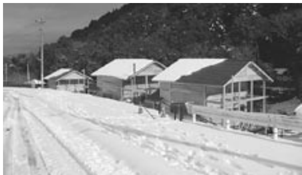
雪に覆われた完成間近のコテージ（帆柱・蛇淵キャンプ場）
