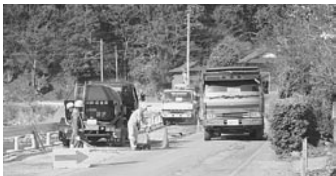
大型車が行き交う国道496号線
