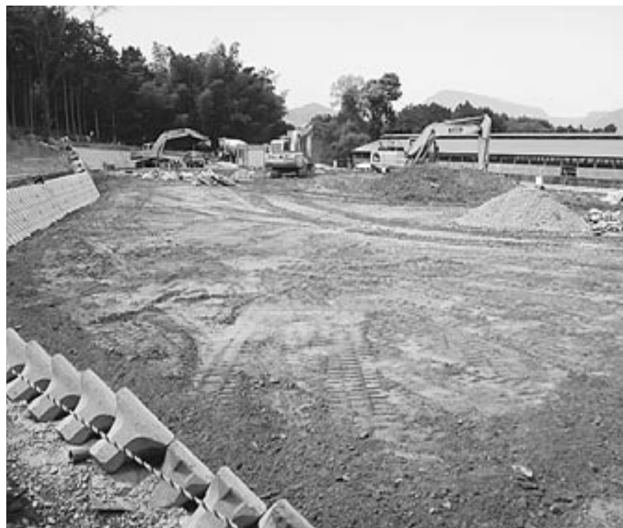
工事中の函師配水池 (勝山)
