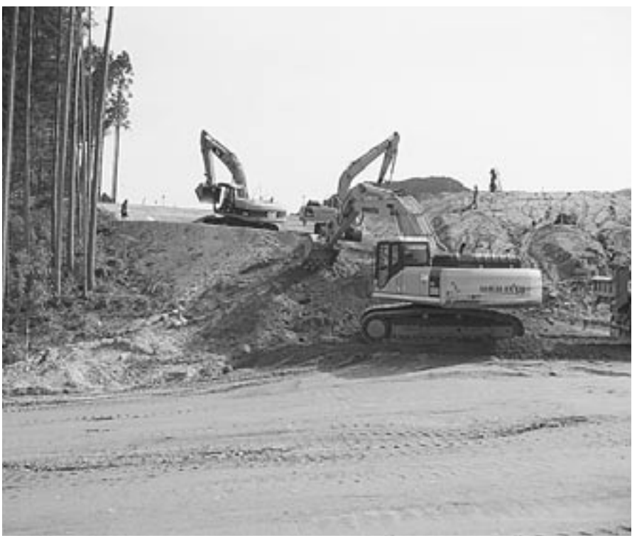
急ピッチで進む伊良原ダム宅地造成（B代替地）
