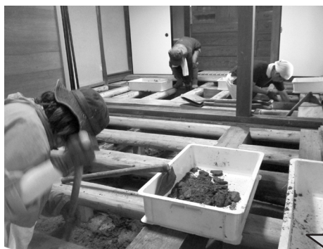
▲床下には最大10cmほどの厚さの土砂が入り込んでいましたが、作業によりとりあえず撤去することができました
