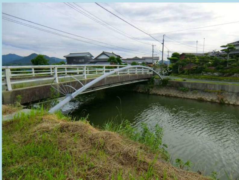
(高屋川・古川橋 水管橋、NCP φ 150)
