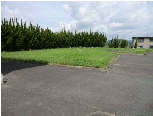
写真 3-5 豊津配水池 (上部張芝) 容量 V = 456 + 344 = 800\text{m}^3/\text{日} 完成年度：昭和 53 年度
