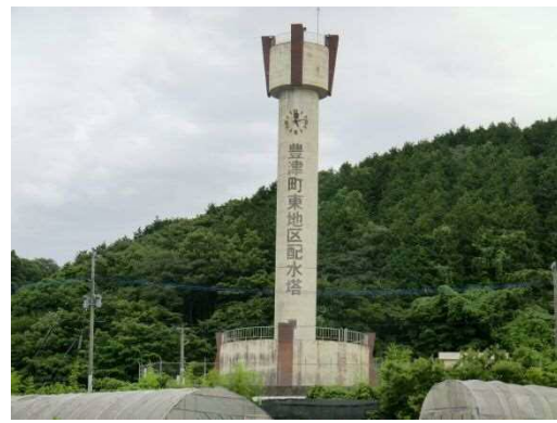
写真 3-6 東第 2 配水池 容量 V = 385 + 42 = 427\text{m}^3/\text{日} 完成年度：昭和 63 年度
