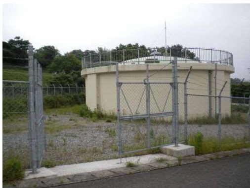
写真 3-7 本庄配水池 容量 V = 640\text{m}^3/\text{日} 完成年度：平成 22 年度
