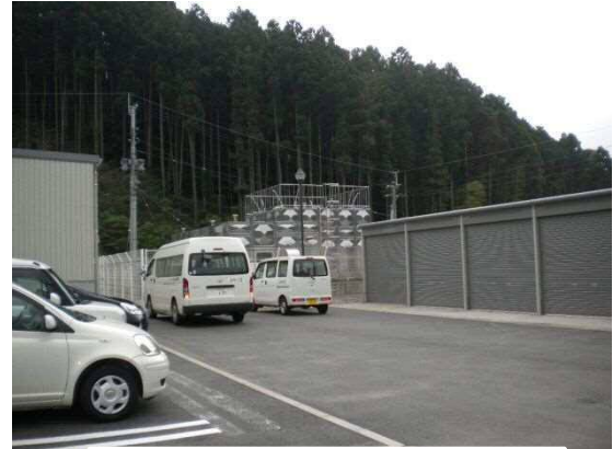
写真 3-4 岩屋河内浄水場 供用開始：平成20年度
