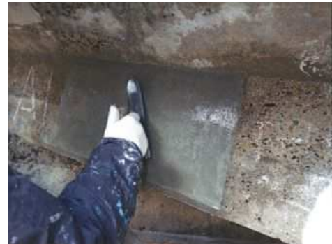
境橋（剥離・鉄筋露出箇所の補修）
