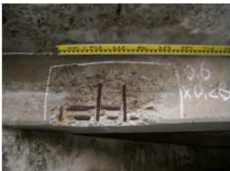
境橋（剥離・鉄筋露出箇所の補修）
